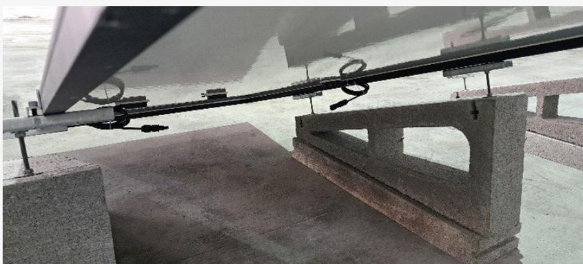
Este sistema de nivelación es muy útil para aquellas cubiertas que tienen grandes formaciones de pendientes para la recogida de agua de lluvia.
