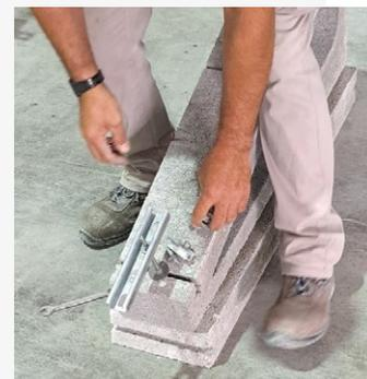
Este sistema nos da un rango de compensación de desnivel entre 60mm y 120mm con una inclinación máxima de 16°, usando tornillos niveladores de M8x150mm. Se pueden aumentar los rangos usando tornillos de mayor longitud.
